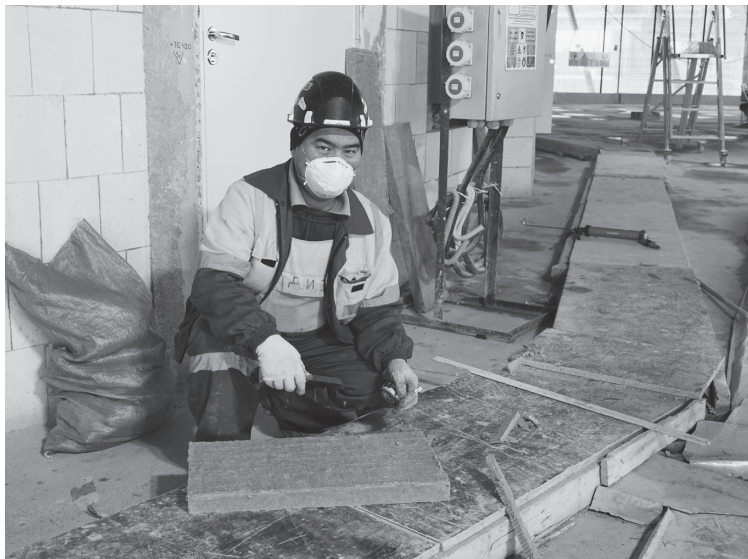
Ein Arbeiter aus Zentralasien auf einer Baustelle in St. Petersburg (picture alliance / dpa / Friedemann Kohler)
