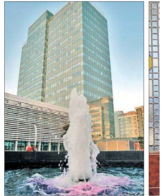
Das neue Regierungsgebäude der Republika Milorad Dodik (rechts) aber fegt das nicht a
